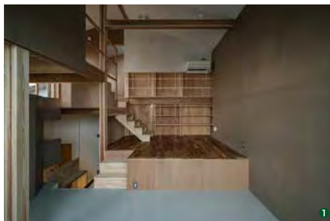
①2階のM、Lリビング。床はメンテナンス性、コスト重視のPタイルを採用。壁はクロスとラワン合板(ステイン塗り)とし、空間にメリハリを設けた。
