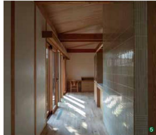
④⑤床材はクルミの無垢材、天井材はトガの羽目板を使用。壁は柔らかさを出すために漆喰に砂を混ぜて押さえすぎないようにしている。造作材、建具、家具についてもナラ、タモの無垢材と突板で統一している。
