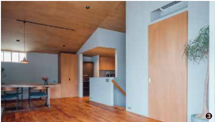
③地元のヒノキ材を使用し、野地板は地元産材のCLTとした。室内フローリングやデッキは無垢材を使用し、長期スパンでメンテナンスをしながら愛着を持って使用できる計画とした。
