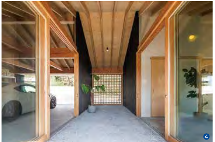
④ポーチの回転扉と開放された3連引戸。
