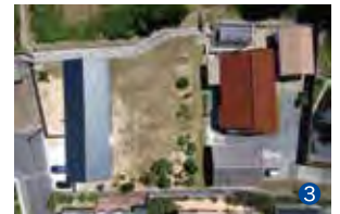
③敷地俯瞰。切妻屋根の群れ。
