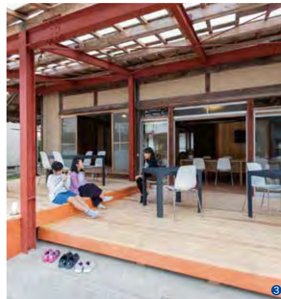
3 ポリカーボネートのテラス屋根によって明るく開放的な空間となり、人を招き入れる。
