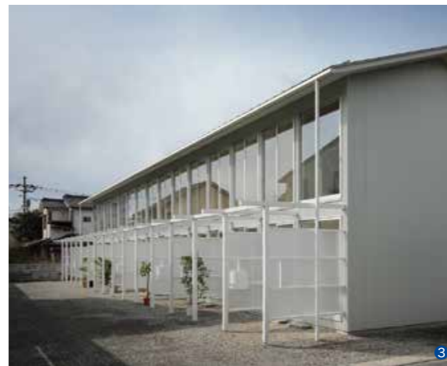
1 90mm角の柱、梁、ポリカーボネートの袖壁で縁取られるテラス。内外の架構が連続する。
