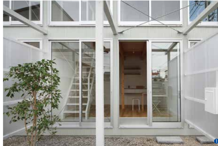
1 90mm角の柱、梁、ポリカーボネートの袖壁で縁取られるテラス。内外の架構が連続する。
