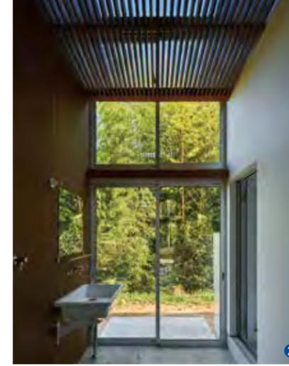
①②③ 1階平面の約半分は基礎打ち土間仕上げとし、その上部の2階床を光の落ちるルーバー床とした。土間とルーバー床の接する短手壁に、トイレの換気窓を除くこの家全てのサッシ6枚を集中して設けた。階を跨いで設けられたサッシは、それ自体が手摺となり余分なディテールとコストを排除。また「集める」ことについて考え、窓を集め、明るさを集め、開放感を集め、抜けを集めている。
