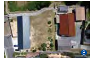
③敷地俯瞰。切妻屋根の群れ。
