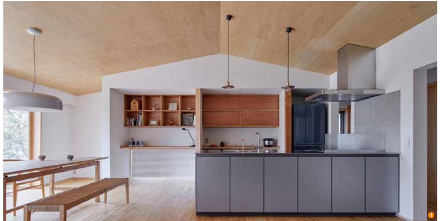
①居間スペースより食事室、台所をみる。既存軸組内にラワン合板の切妻型天井を納めた。
