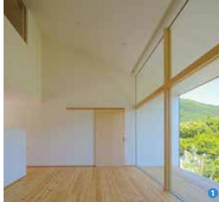
①②住居棟。2階建てだが基本的にワンルームとした。片流れの大屋根にして連続感を持たせている。また、眺望をよくするために1か所の出入り口を除いて、はめ殺しのガラスにした。
