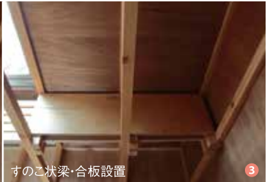
すのこ状梁・合板設置
