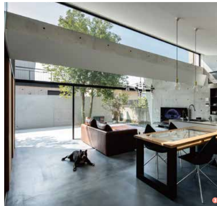
③上部ランマによる重力換気を利用し、エアコンによる空調管理に加え自然換気を積極的に導入。留守中の愛犬の生活環境向を図ると共に、省エネ・省CO 2 にも有効。 ④季節や時刻により刻々と変化する日差しと風を感じることができる、上部ランマ。自然をより身近に感じながら快適な暮らしができるように配慮。 ⑤斜めの屋根スラブによって、北側の趣味空間への採光を確保。南面では外部空間への誘いを促し、北面ではプライバシーを確保。愛犬との暮らし、趣味の暮らし、普段の暮らし。それぞれの暮らしがバランスよく調和する住まいが実現した。
