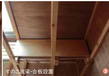
すのこ状梁・合板設置
