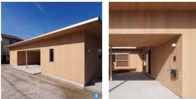
③④外部の杉板は、働き幅を113mm(455mm/4)で製材し、墨出しによる丁寧な割付を行うことで外壁と軒天の目地も全面揃えて貼り付けている。1mほど伸ばした軒は、雨から外壁を守り、内部と中庭へ差し込む日差しも調整している。
