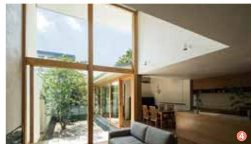
④東側の袖壁と1階分の高さの壁が自由な開口をつくる防火壁となる。中庭とつながる木製サッシの窓まわりにより、採光を確保し、眺望も生み出している。
