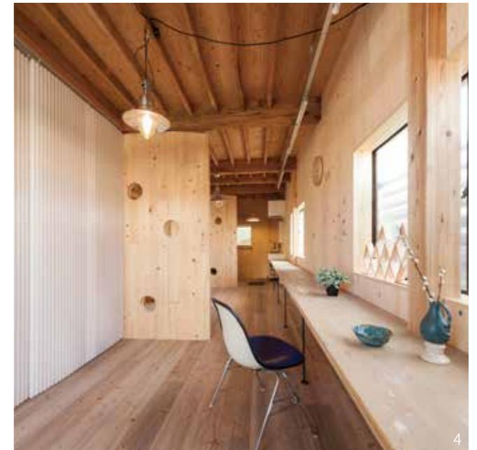
3.4.2階は自営業を営む施主のためのオフィススペース。耐震壁のCLT壁2枚を仕切壁として配置している。トイレのドアは施主からの支給品の古い建具。壁面収納の扉はポリカ波板をカーテンレールに吊るしている。
