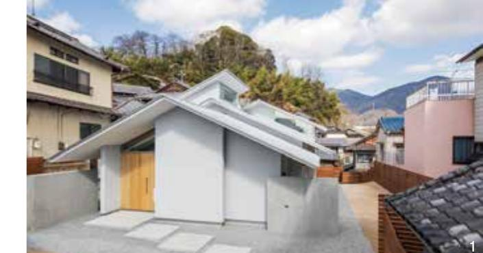
1.南面の開口部を抑えると同時に深い軒を設けることで、直射日光をコントロール。分節した建物ボリュームのいずれにハイサイドライトを設け、効果的に採光している。
