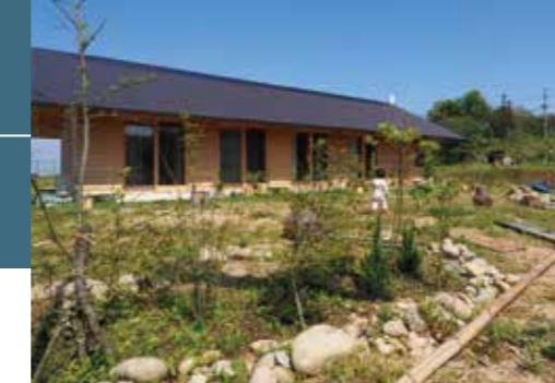
1.引違いに見える窓は、片面をFIXとし、あそびの少ないつくりとして、気密を確保しやすくしている。軒の高さ、軒の出、屋根の勾配を決定する際には、モックアップを制作し検証も行った。
